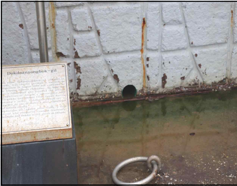
<그림 13> 애추 B 옹벽의 배수구에서 유수가 배출되는 모습
